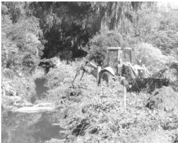
Cañada de los Hornos: la Intendencia ha realizado limpiezas parciales, aunque la obra estaba proyectada en el período anterior.
